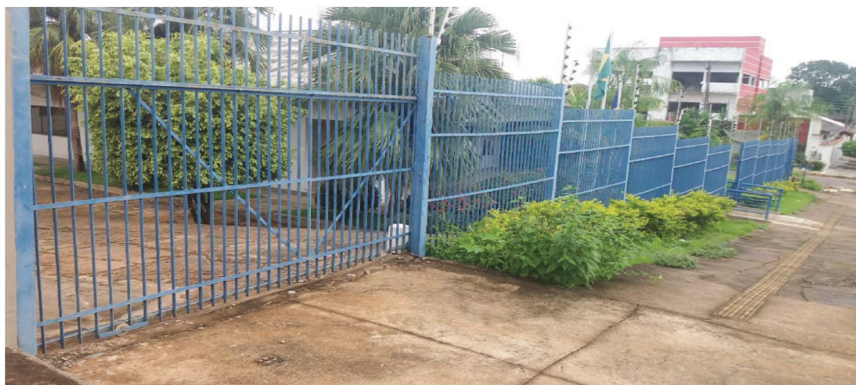
Vista do gradil, calçada e piso tátil
