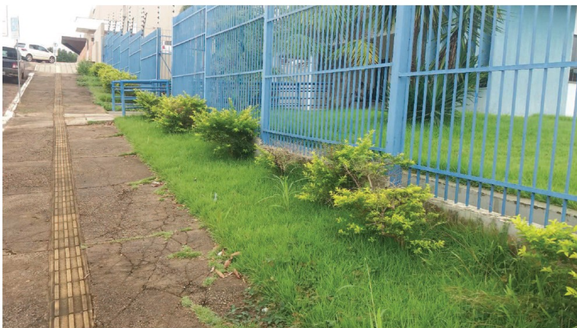
Vista da calçada frontal, gradil e piso tátil
