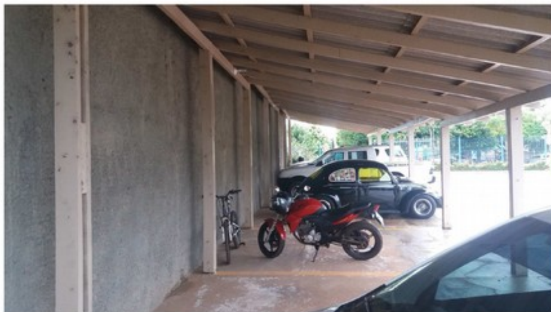
Vista da garagem lateral e gradil frontal
