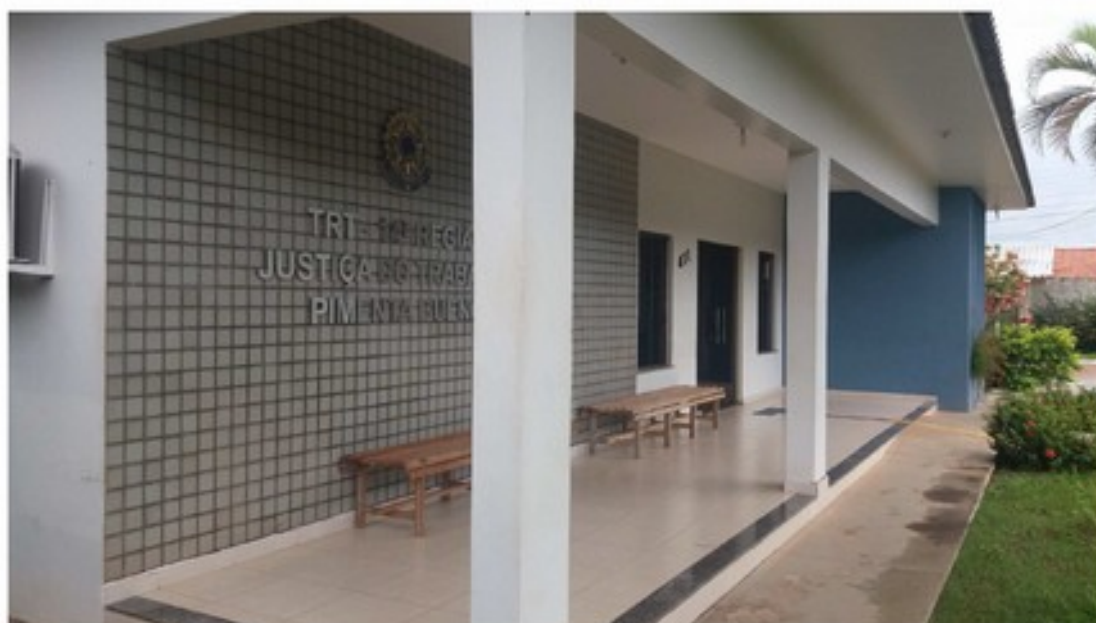
Vista da fachada frontal com brasão e letreiro de identificação do prédio
