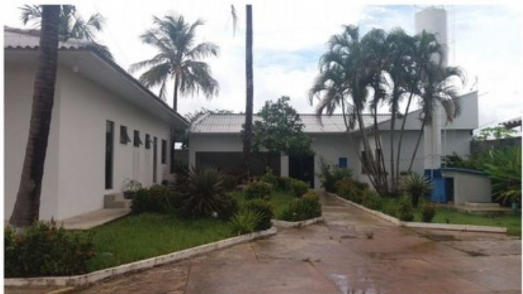
Vista da área de convivência, depósito, abrigo do grupo gerador de energia elétrica, fachada dos fundos do prédio principal e caixa d'água metálica
