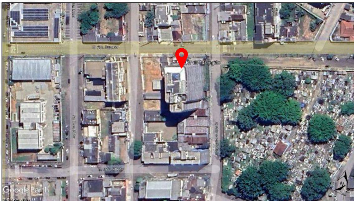
Figura 1: Localização da edificação.
